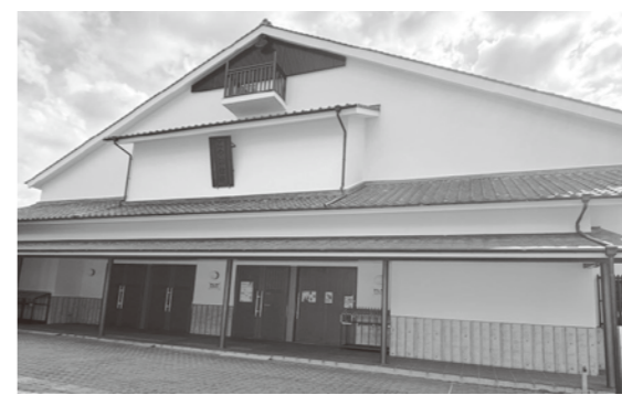
昭和初期の芝居小屋「大正座」の面影を取り入れた「こやのせ座」外観。年間多種多様なイベントが開催される。
